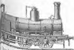
Ατμόμαζα βελγικῶν σιδηροδρόμων.
