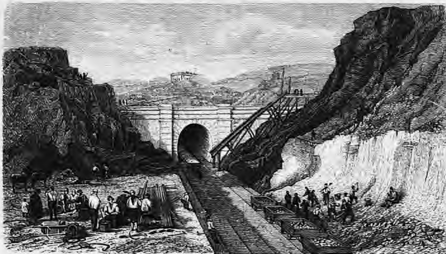
3. Κατασκευή έγχωμάτων και έπιχωμάτων.
