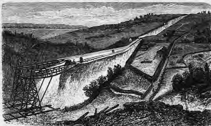
1. Κατασκευή έγχωμάτων και έπιχωμάτων.
