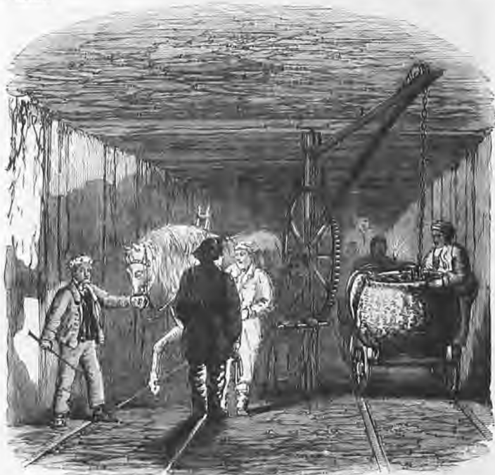
Fig. 48. The Crane Hoister.
