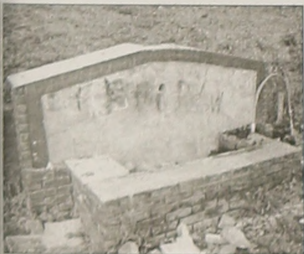
Η βρύση έχει καταστραφεί
