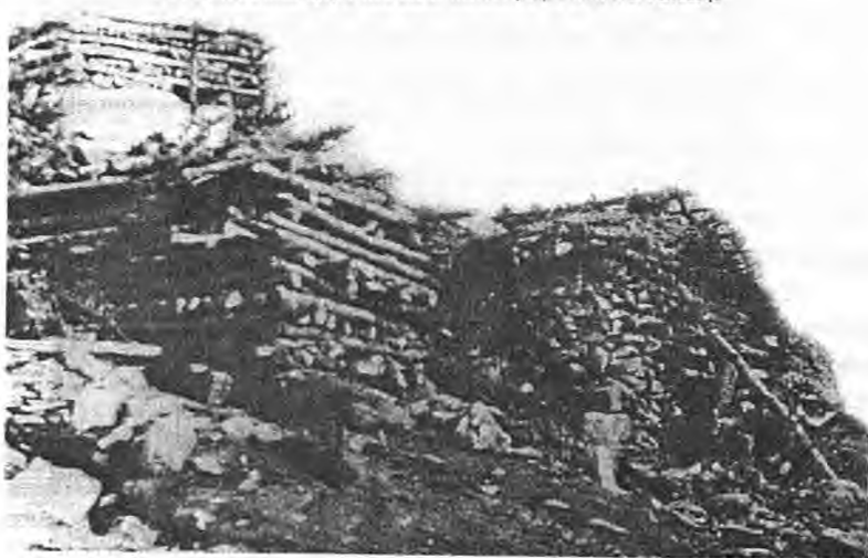
Οχυρωματικά έργα του ΔΣΕ κατεστραμμένα από ναπάλμ
