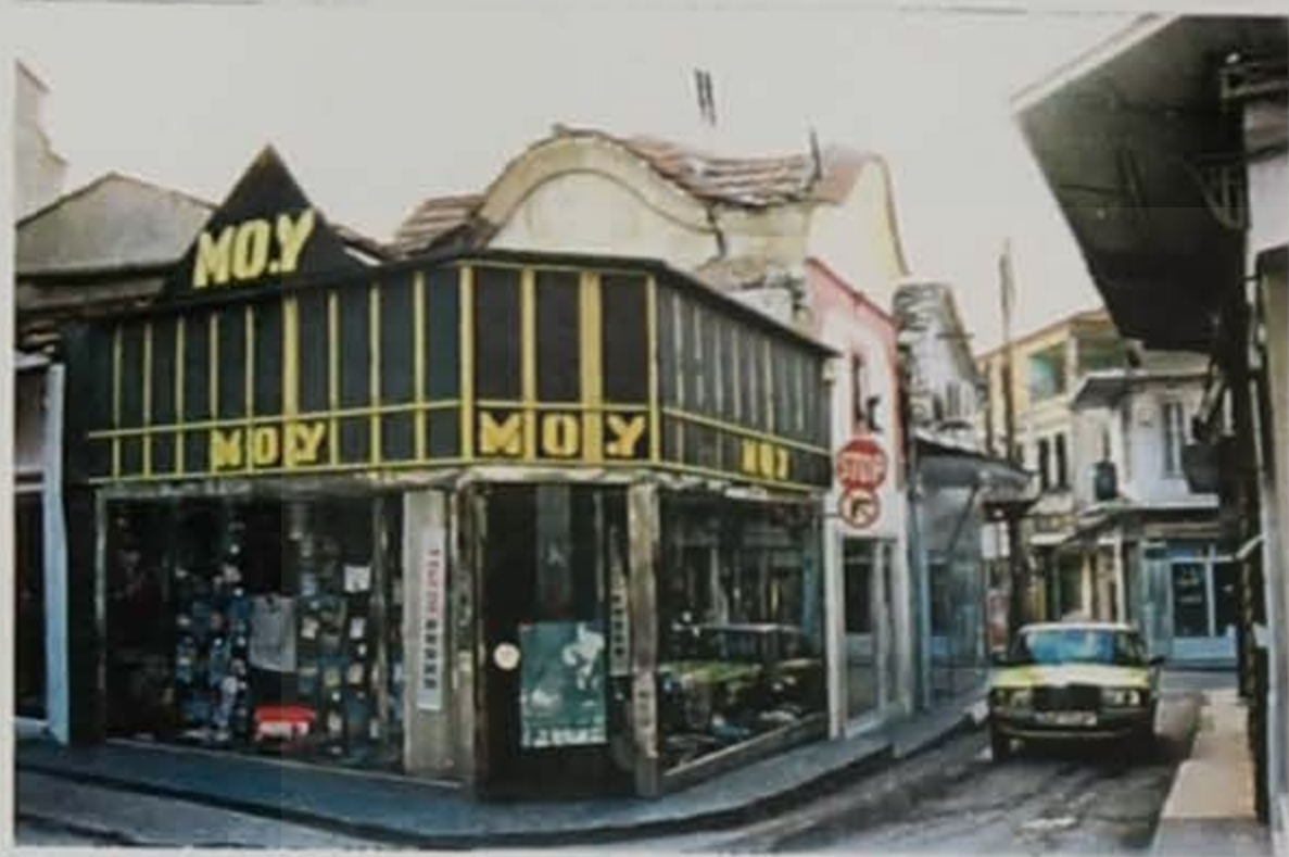
Εικόνα 13. Σύγχρονες επεμβάσεις (πλαστικές επενδύσεις, οδικά σήματα, κυκλοφορία οχημάτων) έχουν αλλοιώσει το χαρακτήρα της παλιάς αγοράς.
