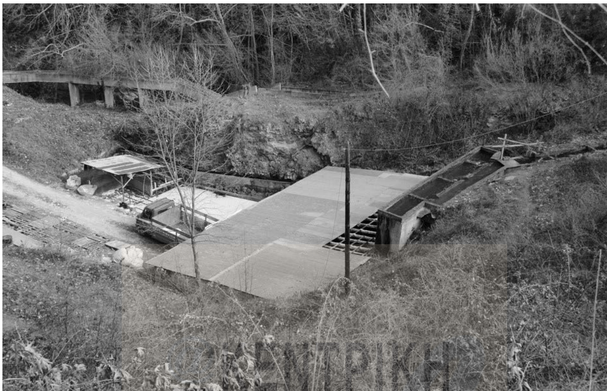
Εικόνα 1: Οι δεξαμενές νερού
