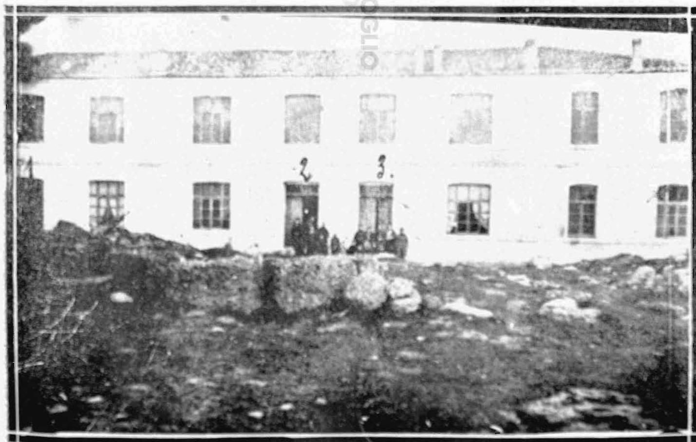
Διώροφοι κοινοτικάι οἰκίαι Καλλιπόλεως
